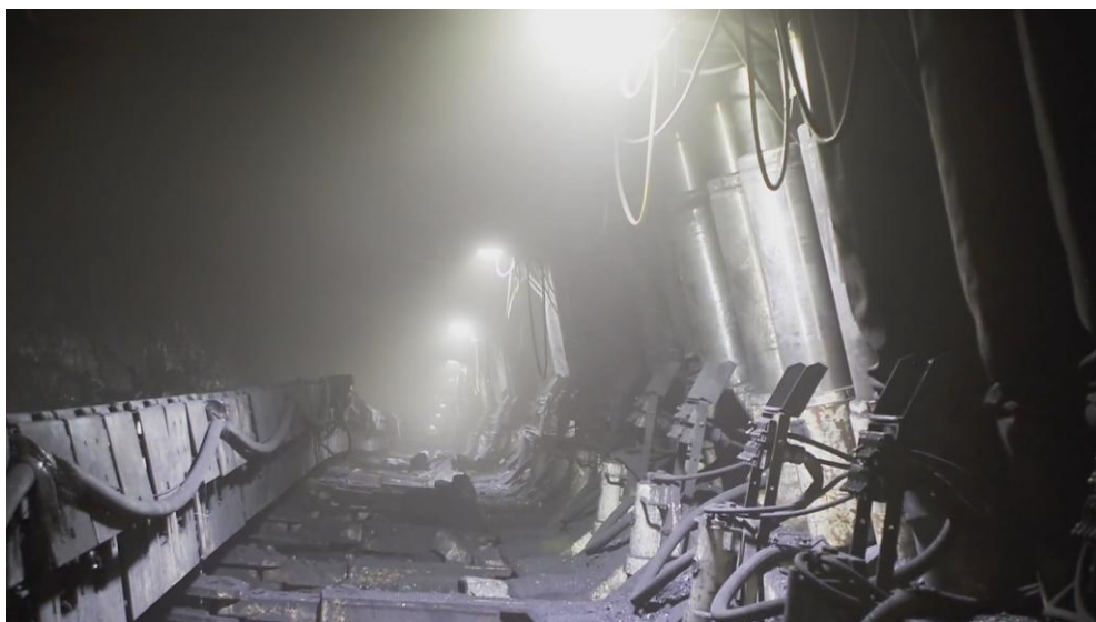
Rys. 18. Ściana 152 w trakcie eksploatacji [2]
